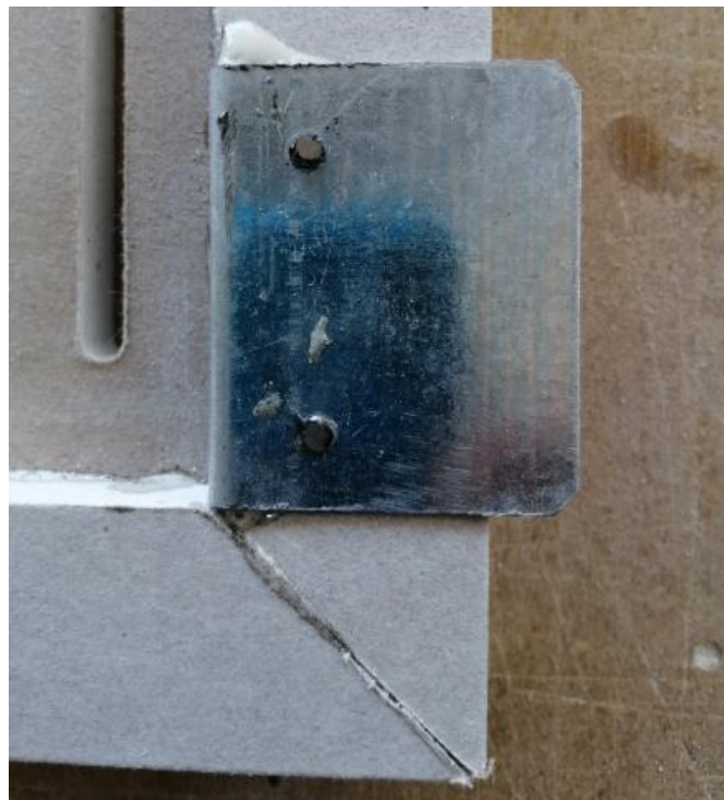
Figura 5. Foto: particolare incollaggio del lamierino per l'appoggio al telaio perimetrale
